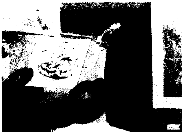
Hình 54 - Vát mép bằng dụng cụ trét
