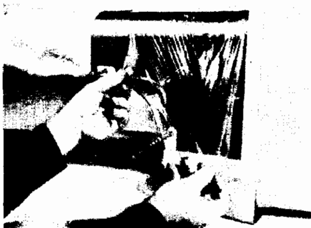
Hình 37 - Che khu vực bị rách bằng màng phủ ngăn cách
