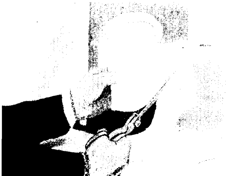
Hình 66 - Dùng miếng mảnh sợi thủy tinh để đắp vào lỗ vá.
